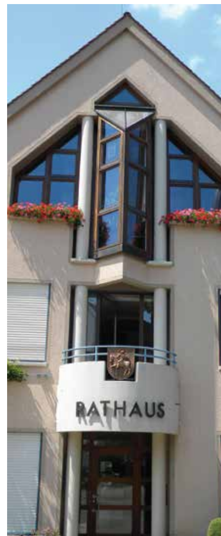
Das Rathaus Oberteuringen ist Sitz des Zweckverbands Gehrenberg-Wasserversorgung.
