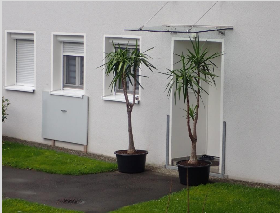
Schott vor Eingangstür
