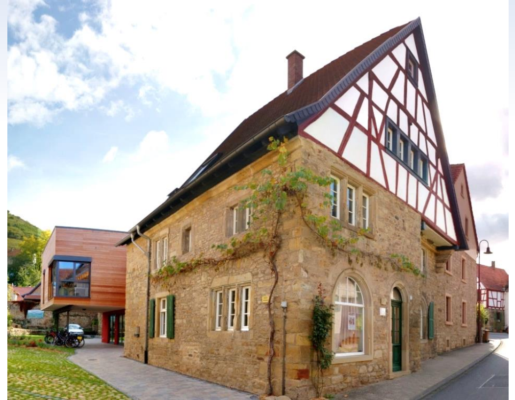
Betriebsgebäude in Odernheim am Glan
