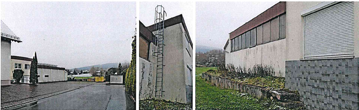
Abb. 8-1: Bestandsgebäude auf dem Flurstück 303/6 mit umlaufenden Attikablech
